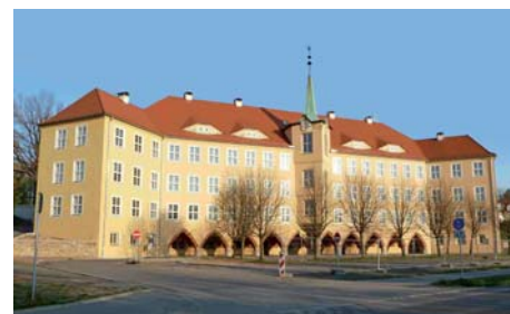
Nordwest - Ansicht nach der Sanierung
