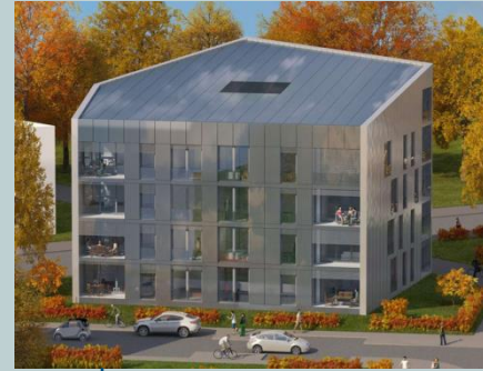
2015: Mehrfamilienhäuser im Effizienzhaus Plus Standard
