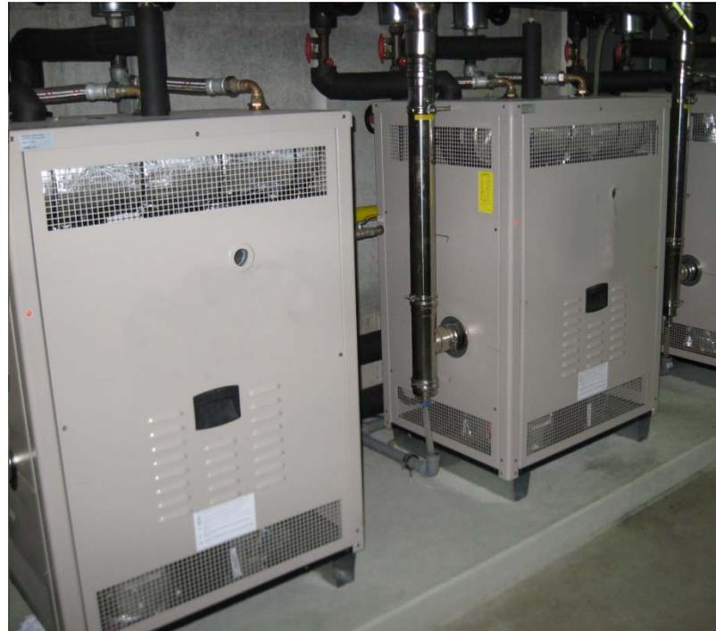
Gasabsorptionswärmepumpenanlage mit Nutzung von Erdwärme
