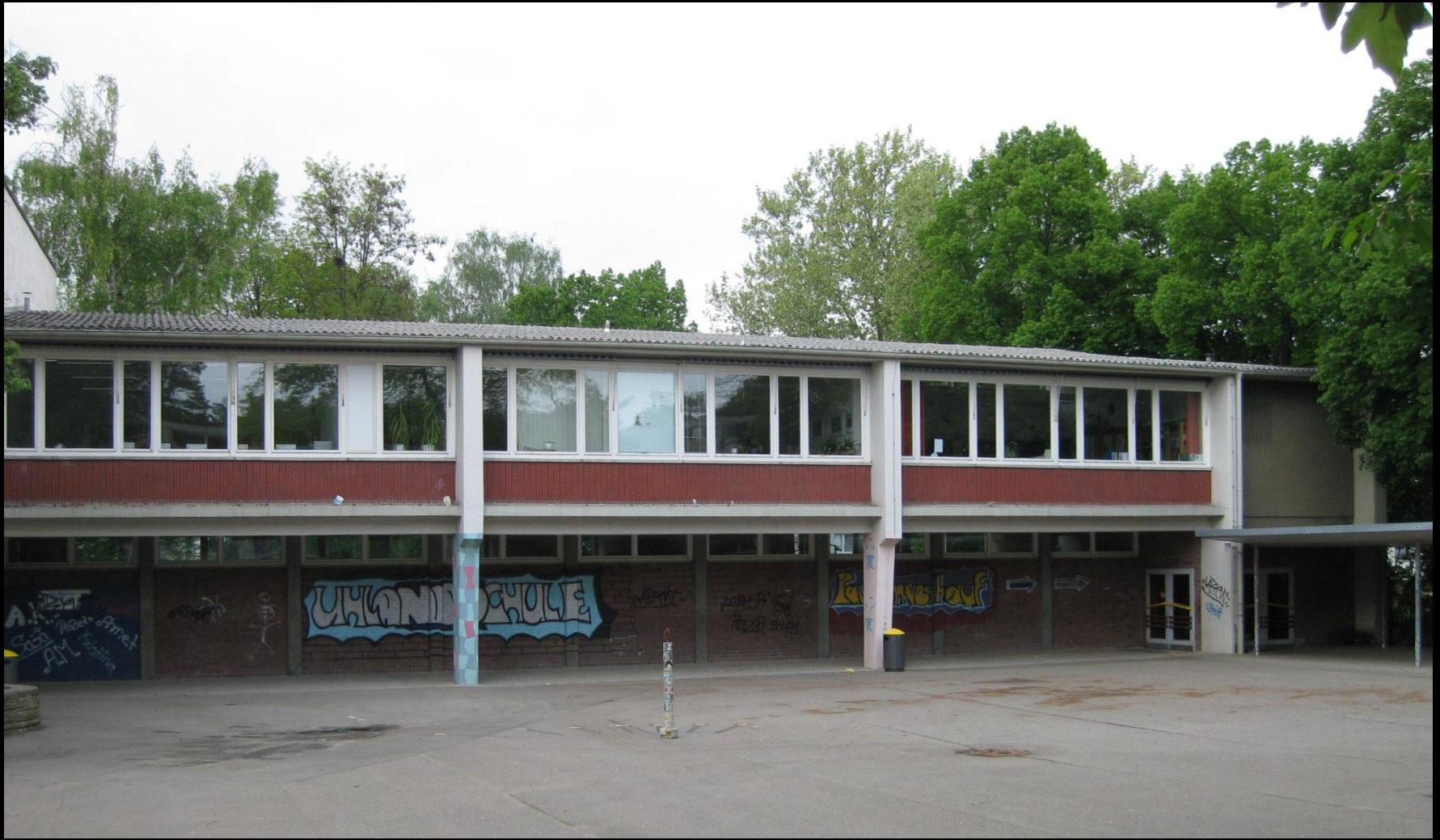
Südseite Hauptgebäude, 2-geschossig
