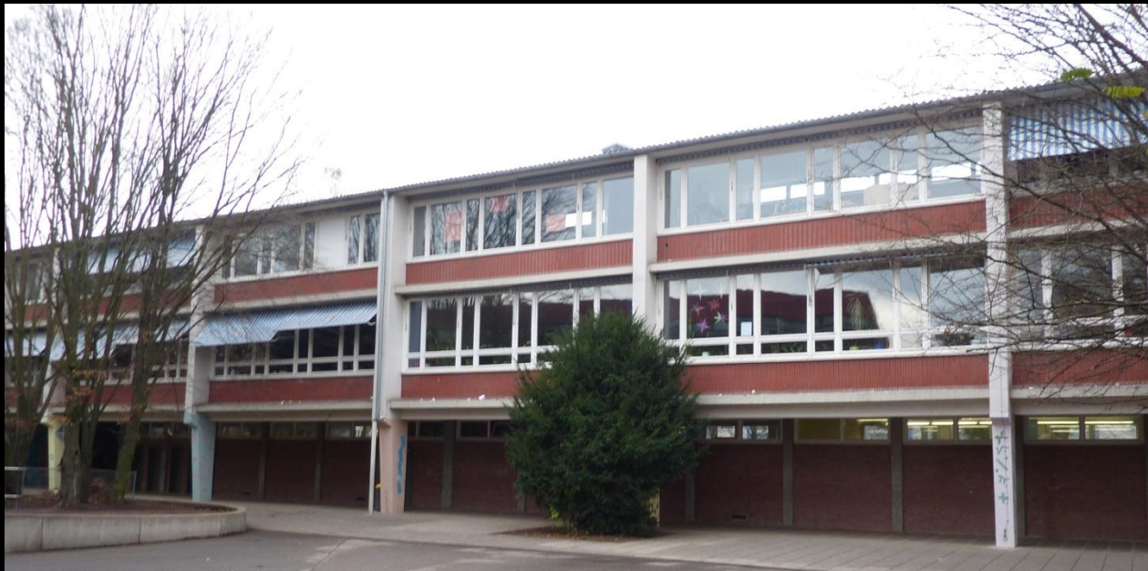
Bestandsgebäude von 1955 Uhlandschule, Stuttgart-Rot
