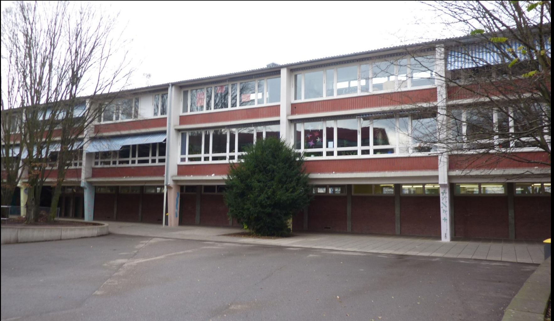
Südseite Hauptgebäude, 3-geschossig
