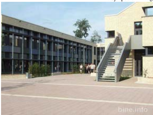
Tagungsort Plusenergie-Grundschule Niederheide © BINE Informationsdienst
