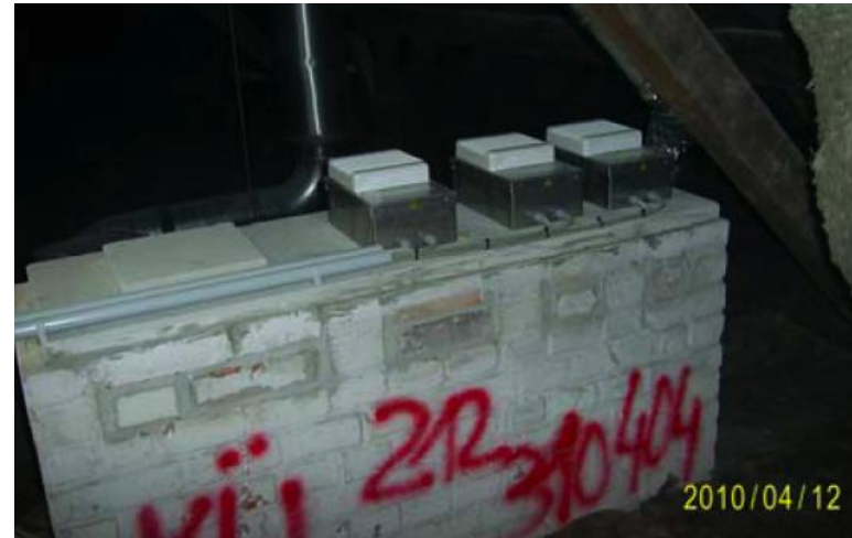
Abluftschächte enden im Dachgeschoss
