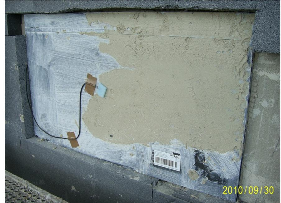
Vakuumpaneele an ausgewählten Fassadenpunkten zur Gewinnung von Messwerten/Erkenntnissen über Feuchte- und Temperaturbeanspruchungen
