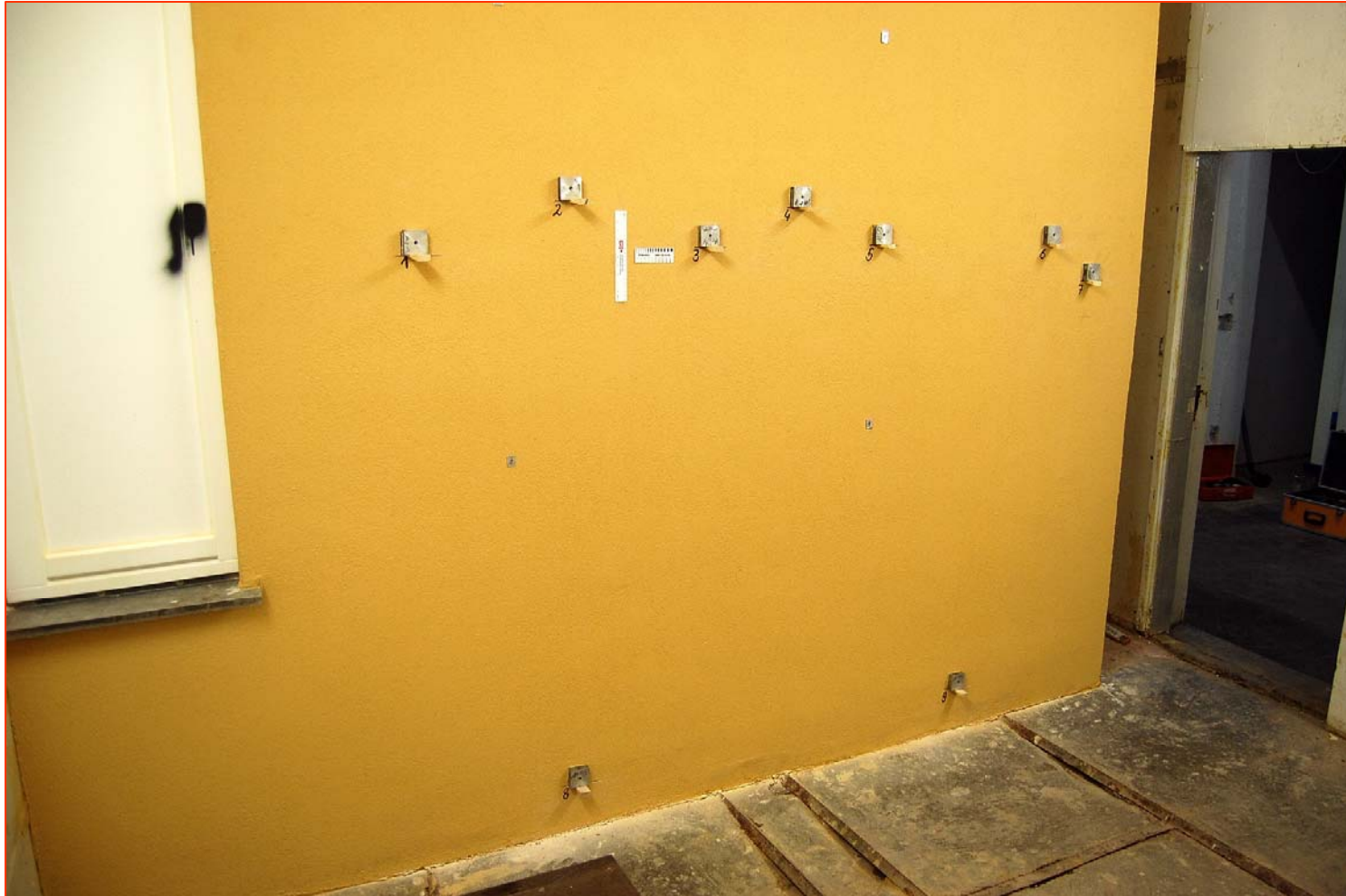
Prüfwand an der MFPA Weimar mit Ecksituation und Fensteranschlag
