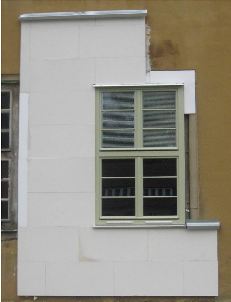
Musterfläche mit 3 cm PUR-Schutzplatten
