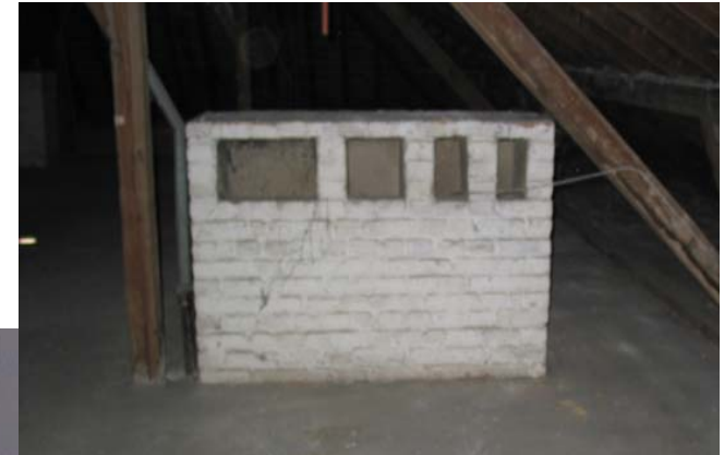
Abluftschächte (enden im Kaltdach)
