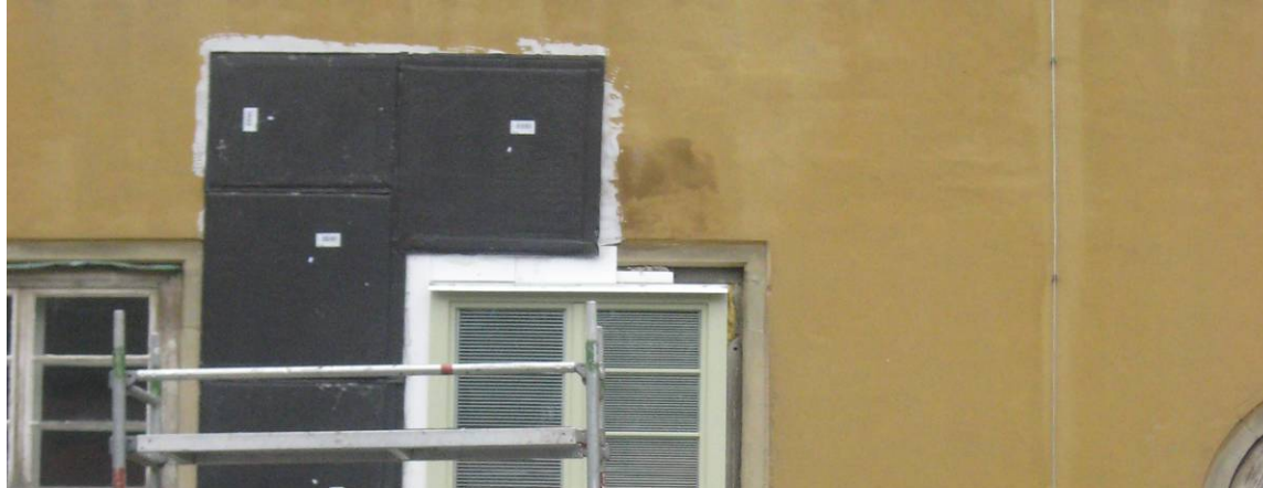
VIP-Platten mit Stufenfalz
