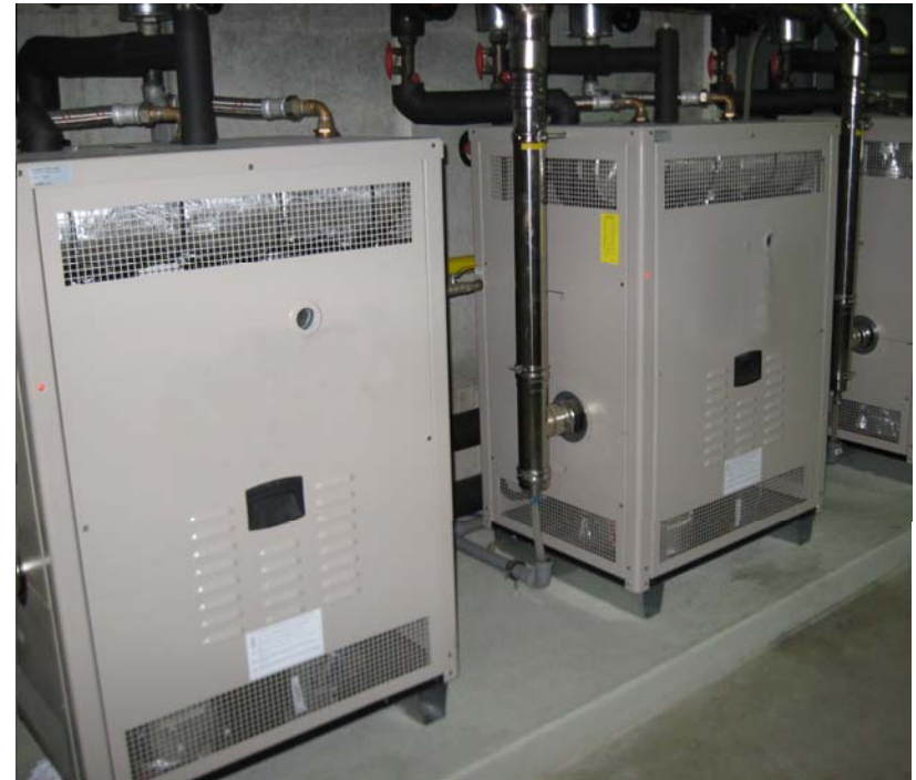
Gasabsorptionswärmepumpenanlage mit Nutzung von Erdwärme
