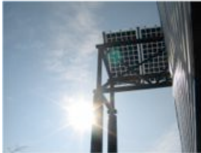
Die solare Zukunft an der Schule beginnt: Am 17. Dezember 2003 erfolgt der Netzanschluss
