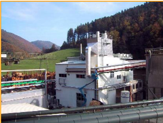
Bio-HKW Dold Buchenbach
