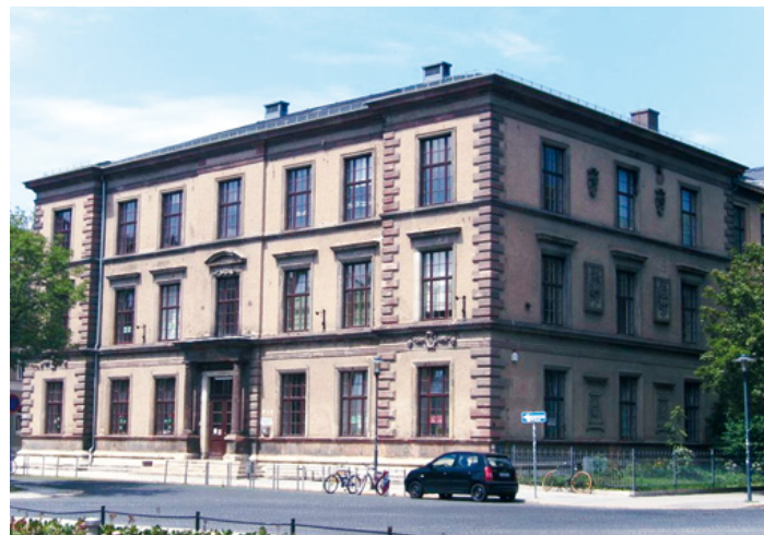
Blick von Süden auf den „alten“ Gebäudeflügel [Quelle: Elster + Henker Architekten]
