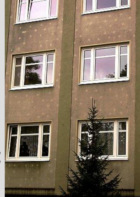
algenbefallenes Wärmedämmverbundsystem auf der Nordseite nach wenigen Jahren Trotz jährlichem Heißdampfreinigen
