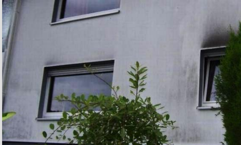
algenbefallenes Wärmedämmverbundsystem auf der Nordseite nach wenigen Jahren Trotz jährlichem Heißdampfreinigen
